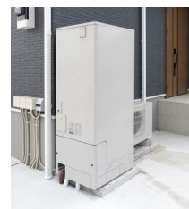
断熱材固定 (電気給湯機)
